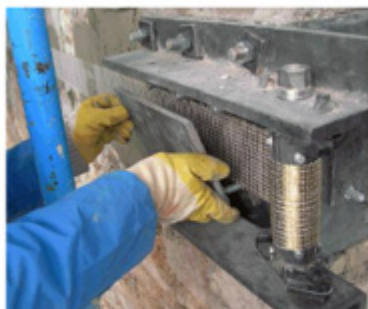
Applicazione della contropiastra metallica sul nastro preteso
