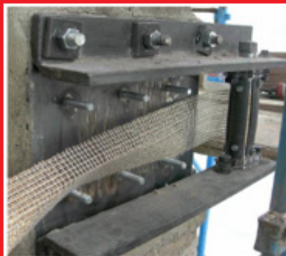
Installazione del dispositivo di pretensionamento
