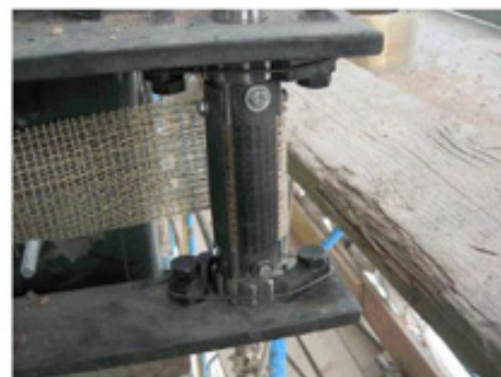
Serraggio del nastro all'interno dell'asse di avvolgimento.
