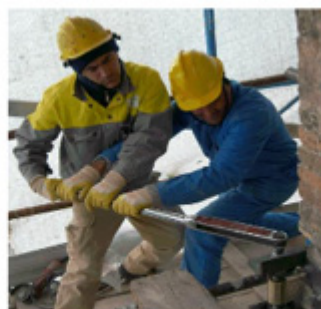
Applicazione della forza di pretensione attraverso l'uso di chiave dinamometrica
