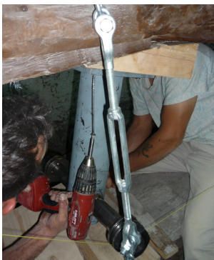
Fig. 4.12 – Fissaggio della biella in acciaio alla zeppa lignea (opportuna-mente sagomata) incollata precedente-mente alla capriata.
