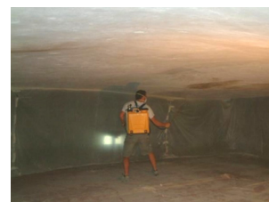
Fig. 4.1 – Preconsolidamento della superficie intradosale del plafone con silicato di etile.
