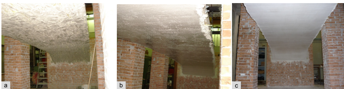
Fig. 3.10 a) – Immagine del primo strato di intonaco.
