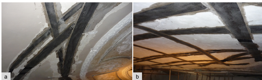
Fig. 4.40 a) – Messa in opera delle fasce unidirezionali sulla superficie intradossale nella parte di volta a raggiera.
