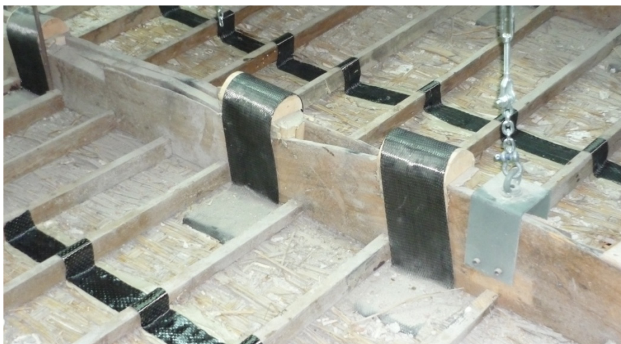
Fig. 4.35 – Fasce in CFRP per sostenere lo stuoioato alla struttura lignea prima del sollevamento. Le fasce sono state messe in opera con lo stesso procedimento dei cavallotti, ovvero incollate con resina epossidica solo sullo stuoioato, e non sui tambocchi in legno.
