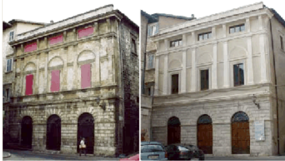
Fig. 1.14 – La facciata del Teatro prima e dopo gli interventi di restauro avviati nel 2001.
