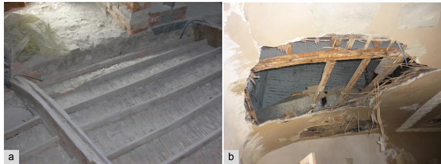
Fig. 2.7 a) – Ammaloramento dei tambocchi, si nota la loro notevole riduzione di sezione.
