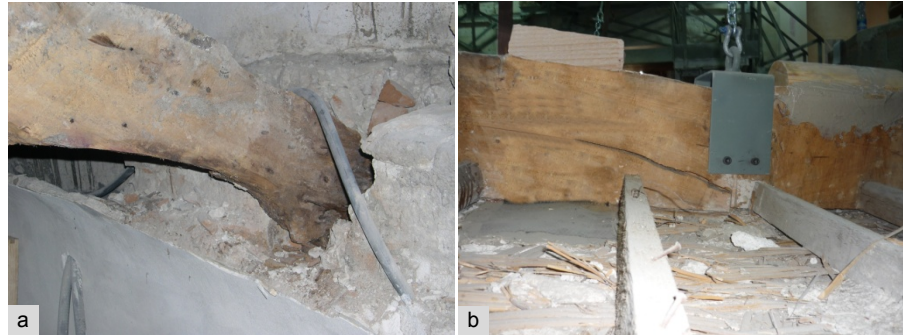
Fig. 2.6 a) – Testa di centina ammalorata; la marcescenza è avanzata e si nota una notevole riduzione della sezione.
