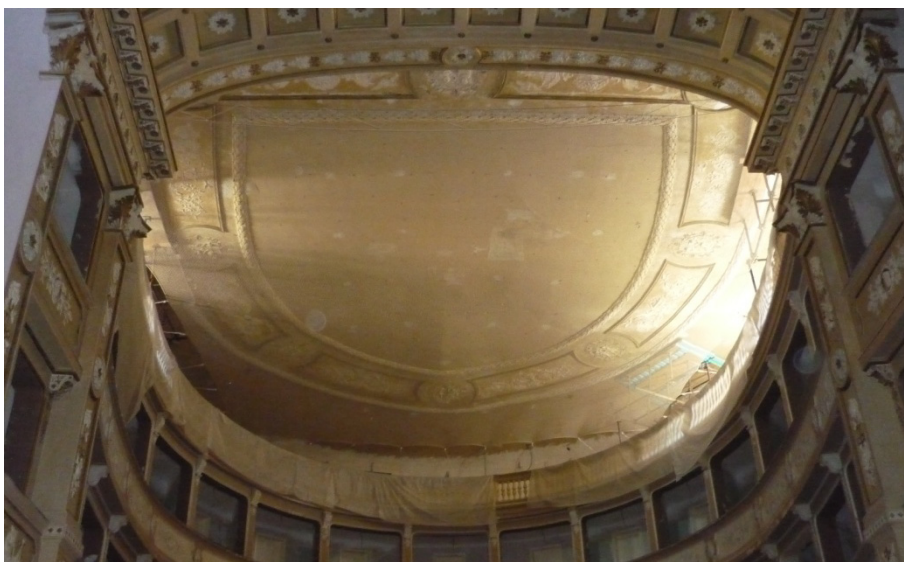
Fig. 1 – Vista dal sotto - palcoscenico del plafone del teatro dei Filarmonici prima dell’intervento di recupero.
