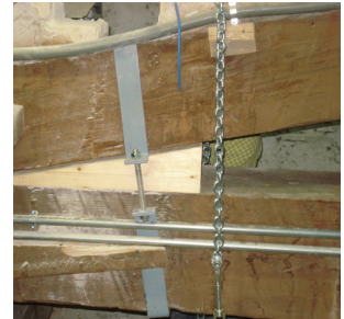
Fig. 4.9 – Fasciatura del nodo puntone – sottocatenata della capriata laterale e inserimento della zeppa di legno.
