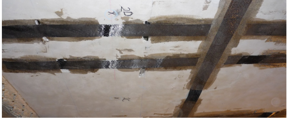
Fig. 4.43 – Individuazione dei punti di riferimento per ogni centina riportata all'intradosso, con i quali è stato eseguito il rilievo degli abbassamenti. Ogni punto è stato indicato con una sigla: nx. La prima lettera indicava il numero della centina, la seconda invece indicava il punto considerato: ad esempio i punti della centina n°2 sono così individuati: 2A, 2B, 2C, etc....
