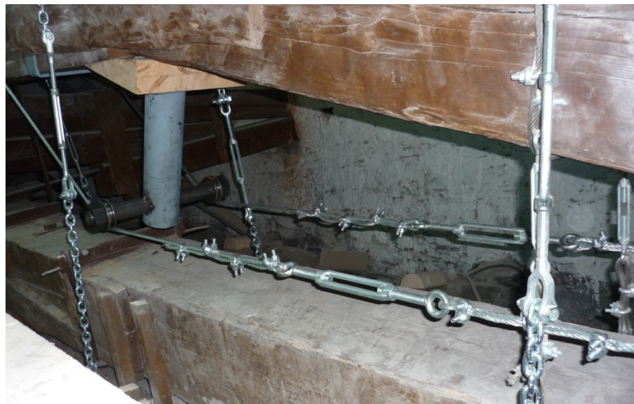
Fig. 4.11 – Intervento sulla capriata laterale dopo la tesatura dei cavi di acciaio.
