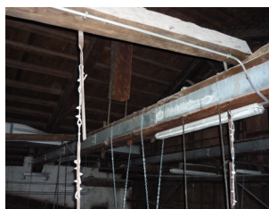
Fig. E.2 – Piastre in acciaio affiancate ed incollate alla catena in legno delle capriate di copertura.
