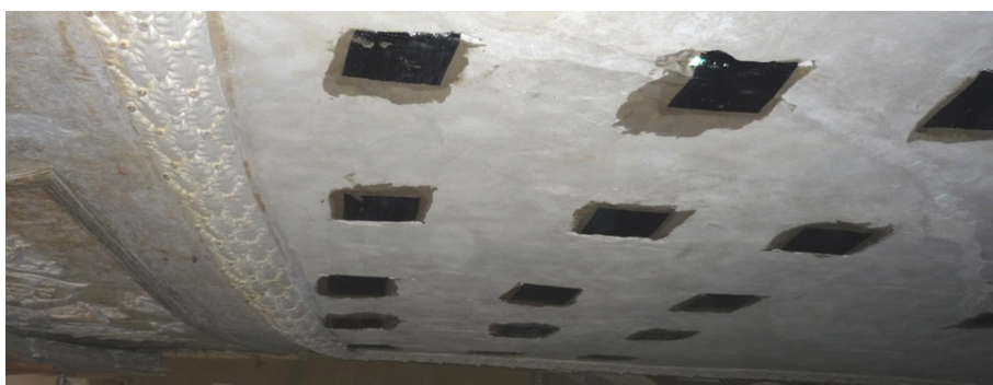
Fig. 4.34 – Risvolti dei cavallotti incollati all'intontaco intradossale. I risvolti sono stati fatti sporgere all'intradosso attraverso i tagli eseguiti nella precedente fase (Fig. 4.31). Una volta all'intradosso, sono stati incollati direttamente con resina epossidica.
