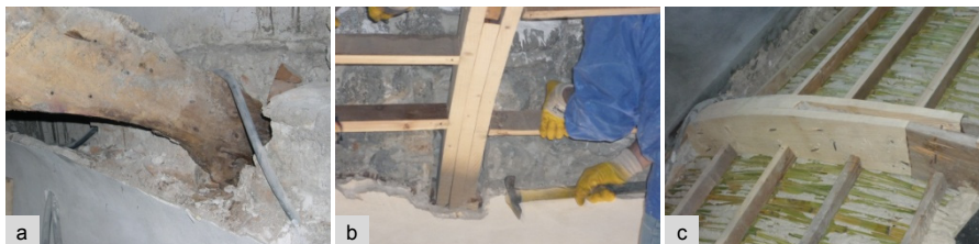
Fig. 4.55 a) – Degradato della testa della centina n°6.
