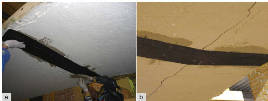
Fig. 3.32 a) – Applicazione della fascia trasversale in fibra di carbonio, larghezza 20 cm.
