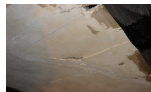
Fig. 4.47 – Fessurazione dell'intonaco causata dal distacco di alcune parti dello stuoio dalla struttura lignea.
