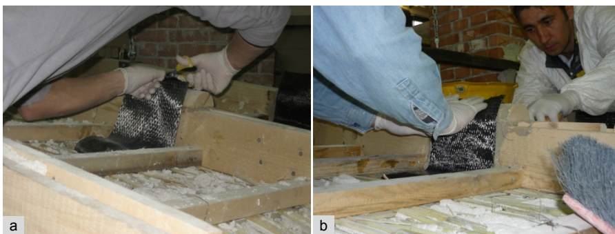
Fig. 3.27 a) – Taglio del cavallotto in sommità. Fig. 3.27 b) – Incollaggio del cavallotto alla centina.
