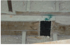
Fig. 4.50 – Cerotti in CFRP per arrestare la progressione della fessurazione della centina.
