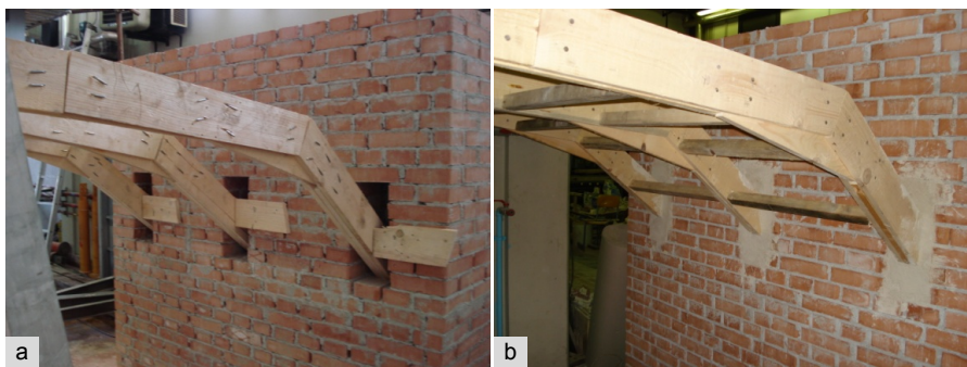
Fig. 3.3 a) – Immagine delle centine inserite all'interno delle tasche lasciate nelle murature.
