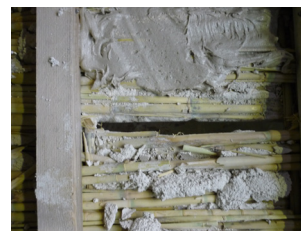
Fig. 3.20 – Estradosso della volta, è visibile la stesura della resina tixotropica e il taglio nella camorcanna.
