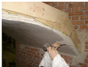
Fig. 3.15 – Eliminazione con scalpello della superficie di finitura liscia.
