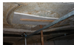
Fig. 4.49 – Disposizione puntellature sulle cornici decorative. Si noti lo strato di polistirolo necessario per non danneggiare la superficie.
