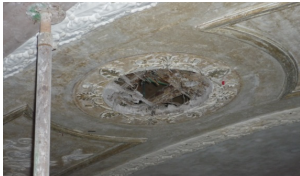
Fig. 4.2 – Cornice in stucchi dopo la rimozione dei medaglioni.
