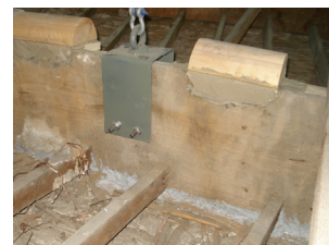
Fig. 4.36 – Cordone in resina epossipoliuretana tra centina e stuoioato.
