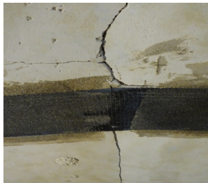
Fig. 4.38 – Fessure non impregnate con resina epossidica.
