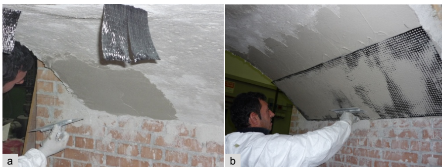
Fig. 3.23 a) - Stesura della malta rasante. Fig. 3.23 b) - Applicazione della rete bidirezionale.
