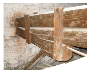
Fig. 4.7 – Appoggio della capriata a sostegno della passerella.
