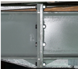
Fig. 4.16 – Realizzazione del collegamento flangiato bullonato.
