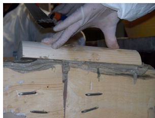
Fig. 3.16 – Posa in opera del cuneo di legno arrotondato per facilitare la posa in opera del cavallotto in CFRP.
