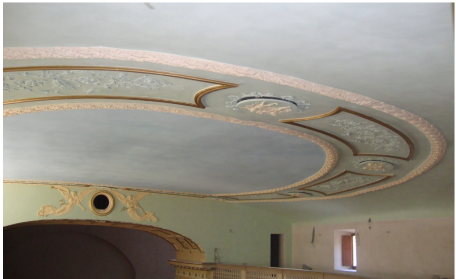
Fig. 4.61 – Il plafone dopo l'intervento di recupero.
