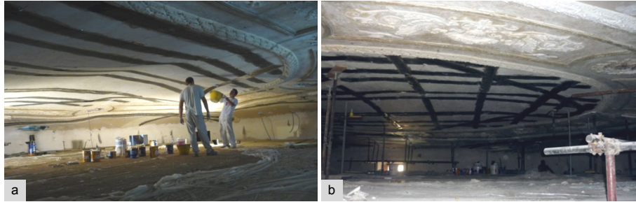
Fig. 4.50 – Cerotti in CFRP per arrestare la progressione della fessurazione della centina.
