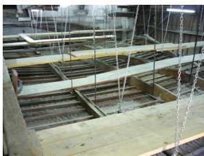
Fig. 4.30 – Messa in opera delle passerelle appese ai puntone delle capriate di copertura.
