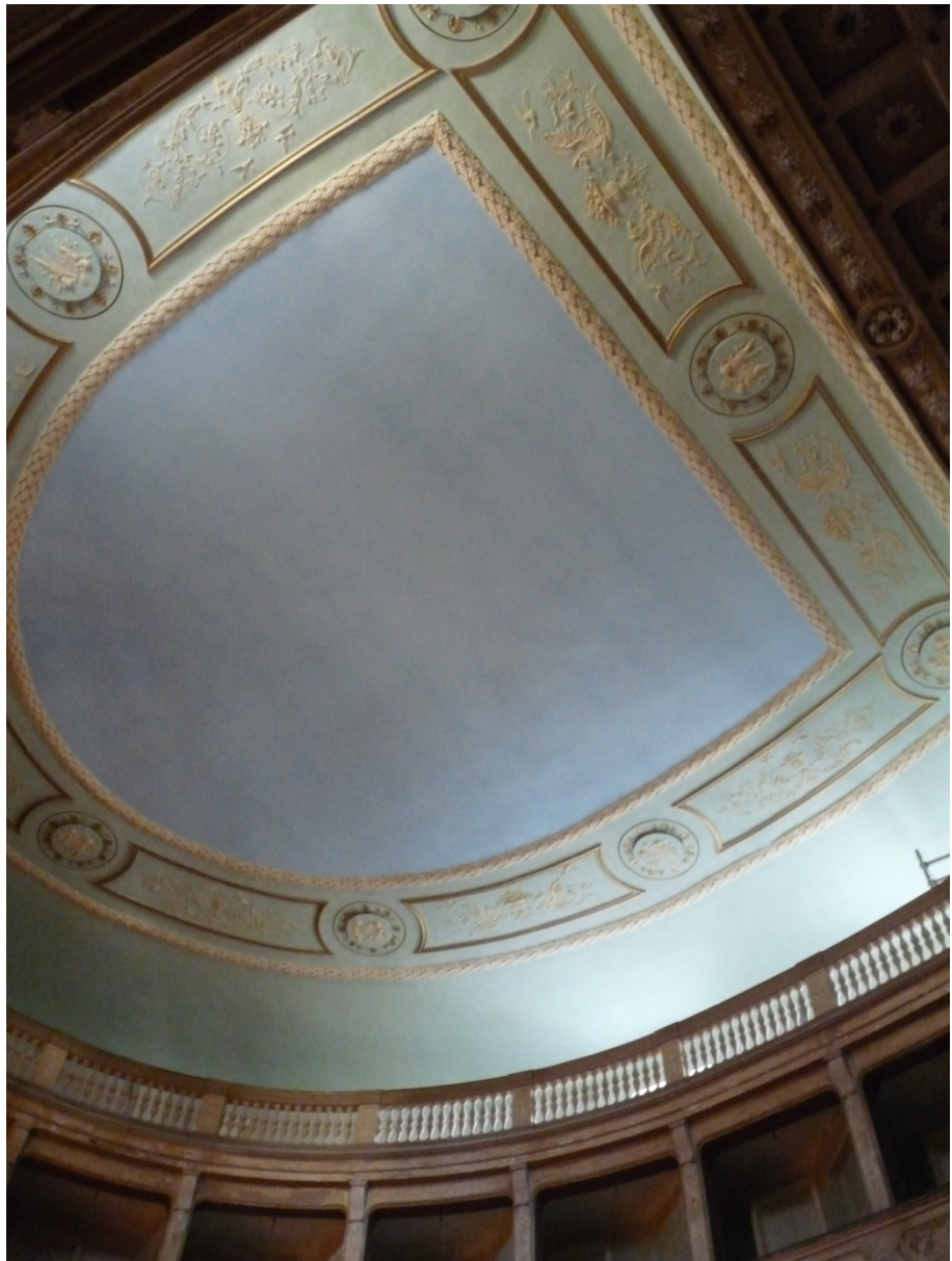
Fig. 5.7 – Veduta prospettica del plafone dopo gli interventi di restauro.
