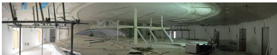
Fig. 2.8 – Panoramica della volta esaminata.
