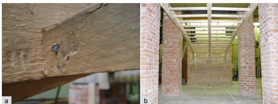
Fig. 3.7 a) – Particolare della chiodatura obliqua, detta anche alla "traditora", del tamboccio sulla centina.
