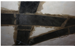
Fig. 4.52 – Incollaggio delle fasce all'intradosso, con la posa in opera di un "cerotto" nel punto di sovrapposizione tra i due lembi delle fasce per garantire la continuità.
