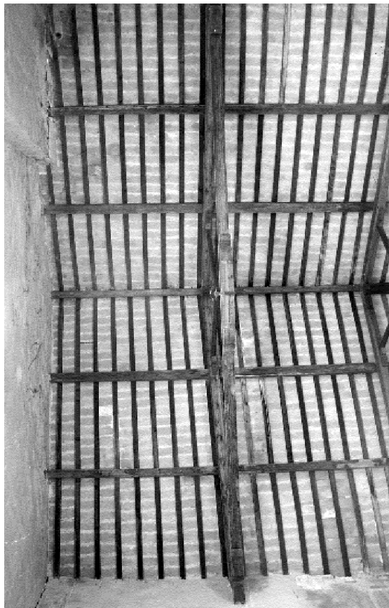
Deformazione del piano di falda in travetti e pianelle con perdita di verticalità delle capriate (tendenza all'accatastamento) e trasmissione di spinta al timpano esterno, in cui si attiva un meccanismo di ribaltamento (vedi foto inferiore). Caldarola, chiesa di S. Maria nella Valle. Il fenomeno è da mettere in relazione al comportamento rigido-fragile dell'impalcato.
